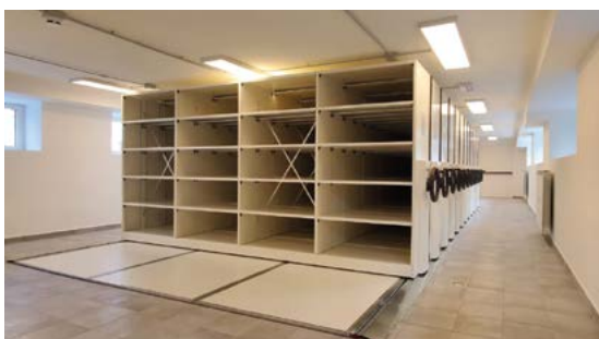
Réalisation d'un faux plancher.
